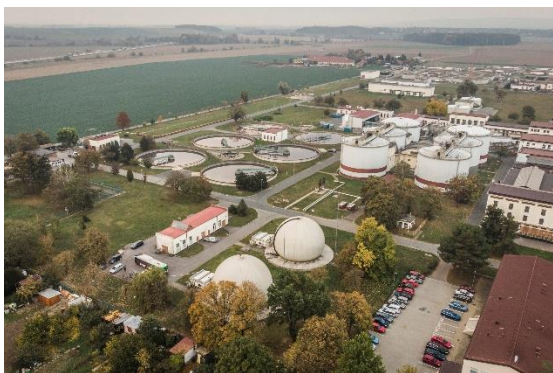
Areál čistírny odpadních vod Modřice
