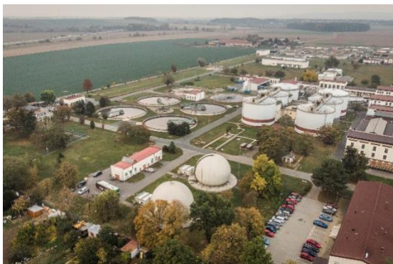
Areál čistírny odpadních vod Modřice
